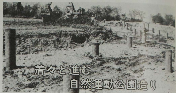
▲くい打ちも終り建設が進む流水プール
