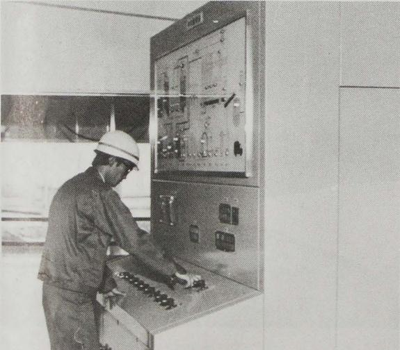
完全に自動化された排水処理施設の運転状況や故障箇所が一目でわかる「中央操作盤」が、電気操作室に備えつけられています。
