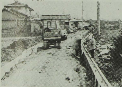
市道新設改修費も大幅増額（写真は甲神川北道線拡幅工事）
