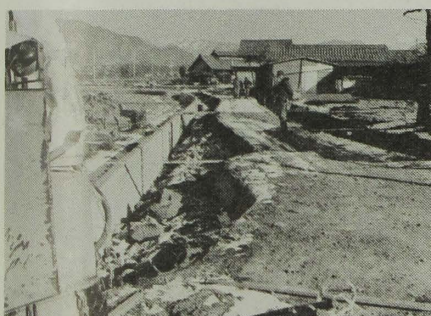
進む集落道路の改修工事（農村総合モデル事業・上青木で）
