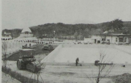
自然運動公園50メートルプール完成間近(写真) 今年はフィールドアスレチックが…
