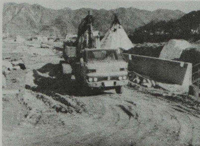
市道の整備順調に進む (小島神畑線拡幅工事現場)
