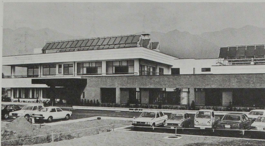
完成した老人福祉センター。屋根には178枚のソーラシステムの集熱板があります。
