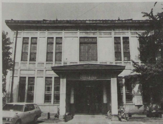
常田会館(写真)跡にコミュニティ防災センターを建設
