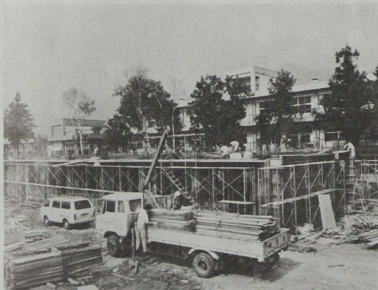
校舎の増築工事が進む神科小学校
