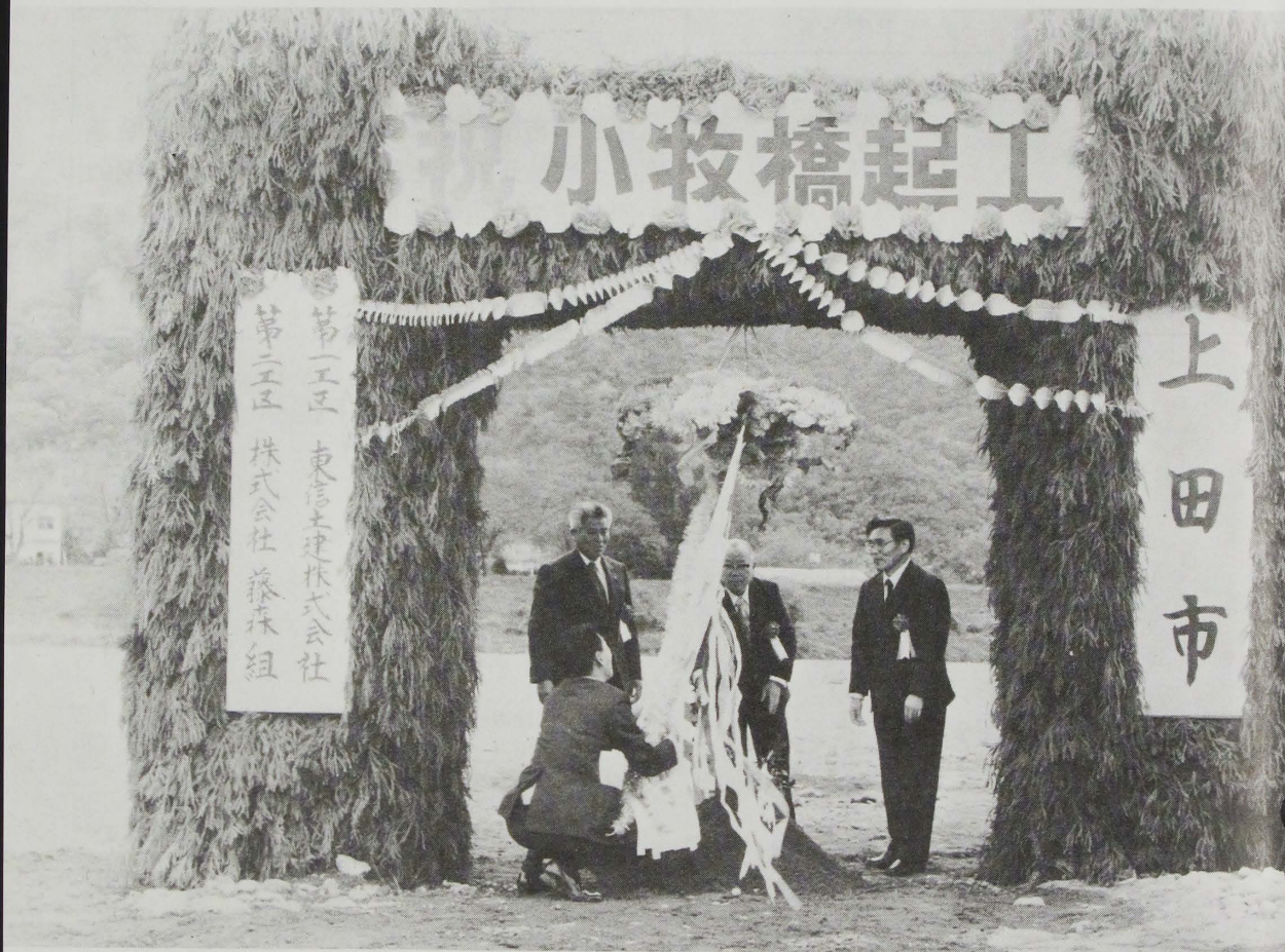
10月6日、千曲川市民緑地（上堀グランド）で小牧橋の起工式が行われました。 小牧橋は橋長約376m、幅員10mで昭和58年度完成の予定です。この小牧橋が完成しますと、交通 渋滞の緩和と地域産業発展のうえに計り知れない利益をもたらすものと期待されています。
