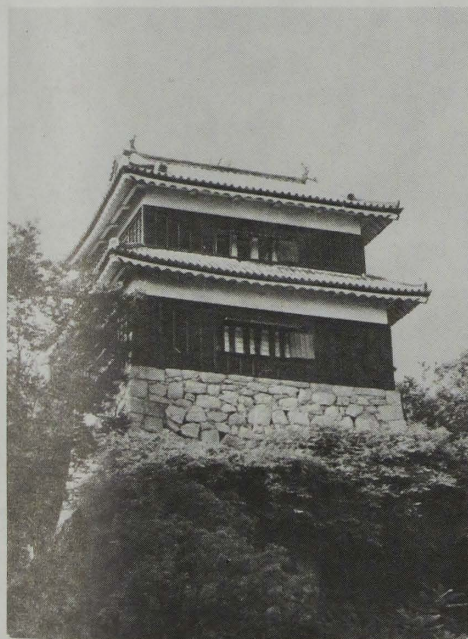
今年度改修される上田城西櫓(やぐら)
