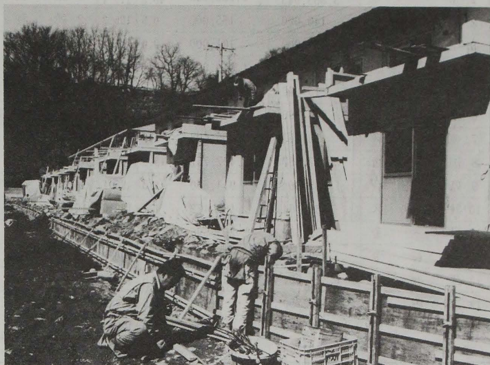
建設中の市営住宅古里団地。
