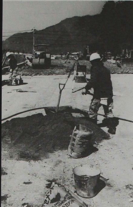
早期開通をめざし建設中の秋和上堀線
