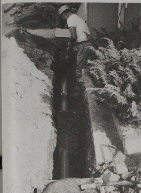
下水道の排水設備工事
