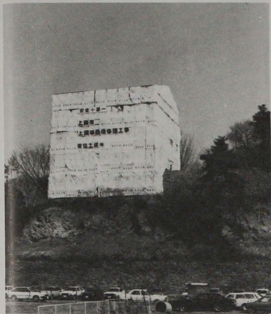
継続事業として修理が進む上田城西櫓(やぐら)
