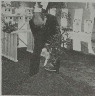
上田市・真田町じんがい焼却場組合の新焼却炉工事着工にあたって、11月30日、現地で安全祈願祭が行われました。 新焼却炉は焼却能力100トン炉2基で、現有の敷地内の北側に建設されることになっています。
