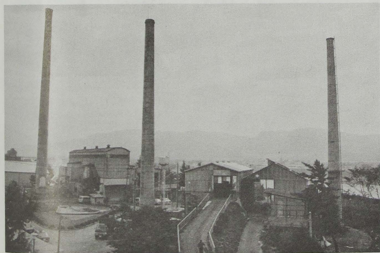
現在のじんかい焼却場。手前の左側に新焼却炉が建設されます。
