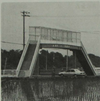
小牧川辺線の新設、川原柳豊里線の横断歩道橋工事(写真)などに力が注がれました。
