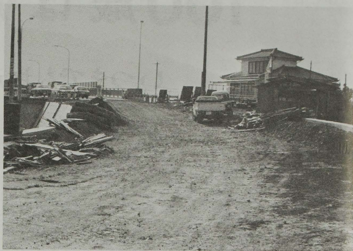
工事が進む小牧橋の取付道路（上堀地籍側）
