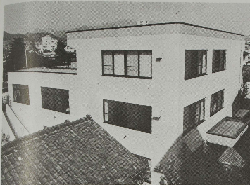
上田市の中心部に完成した上田市福祉会館
