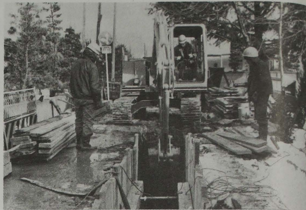
昭和56年から始まった第三期工事(常磐町で)
