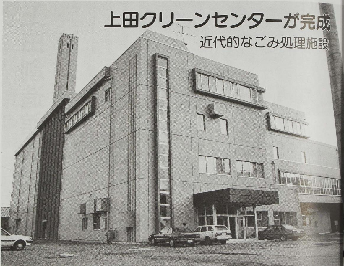
上田市・真田町じんかい焼却場組合が、昭和58年11月から3か年事業で泉平地籍の千曲川べりに建設を進めていた新しいごみ焼却場「上田クリーンセンター」が完成し、11月25日には関係者約100人が出席して竣工式を行いました。このクリーンセンターは、鉄筋コンクリート4階建てで総事業費は約28億円、1日当りの処理能力は200トン(100トン炉・2基)あります。3階の中央制御室では、コンピューターや監視用モニターテレビを使って、ごみの燃焼状況などをコントロールしています。また、新焼却炉は丸1日かけて完全燃焼させる方式を採用しており、煙や臭気が外部に漏れないよう公害防止にも力を入れています。
