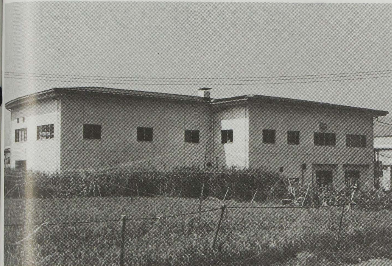
完成した家庭雑排水汚泥処理施設
