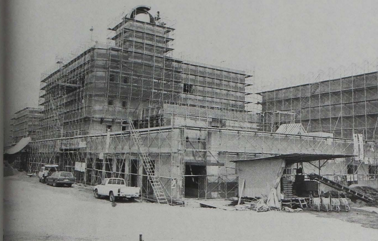
今年度完成を目指して工事が進められる創造館
