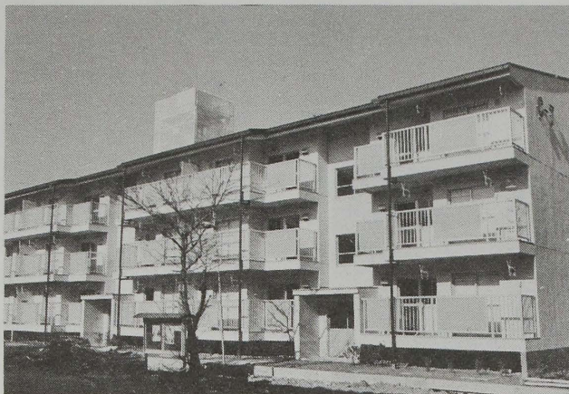
千曲町団地は、昨年12月に第1期工事が終了(=写真)し、昭和60年度からは2か年で第2期工事を進めます。
