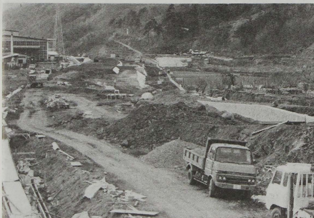
上田バイパスは、上塩尻から浅間山ろく広域農道まで(第1期区間) 5.6 kmの建設工事に全力が注がれています。
