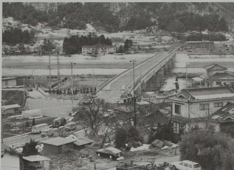
昭和60年度早期開通を目指す小牧橋は、現在その取付道路の建設を急ピッチで進めています。
