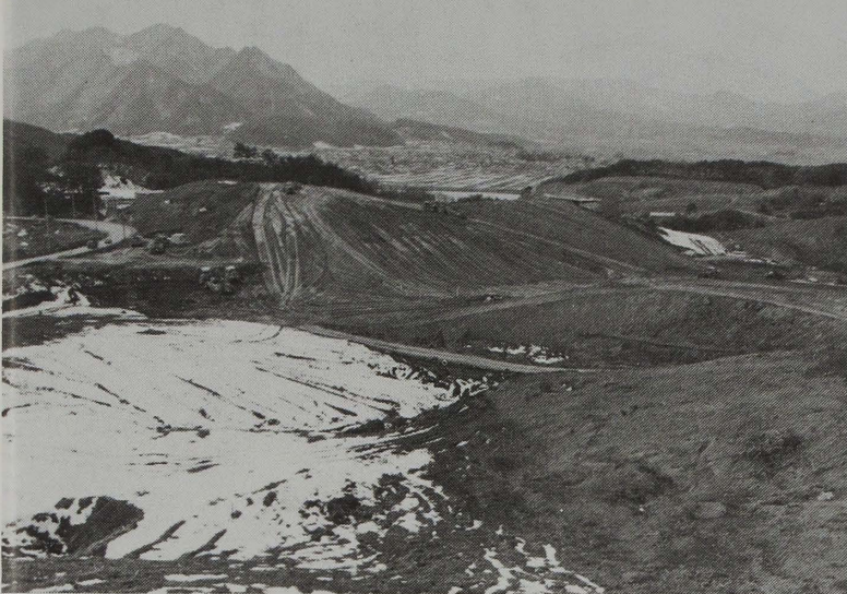
東塩田林間工業団地は、市内富士山の山間地約23.5ヘクタールに建設されますが、現在はその造成工事が進められています。
