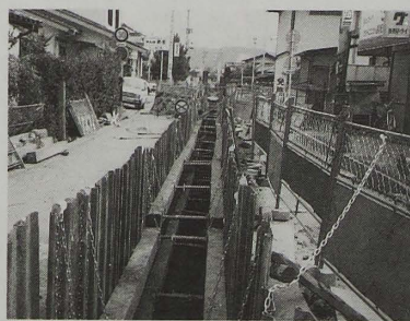
城北地区の下水道工事
