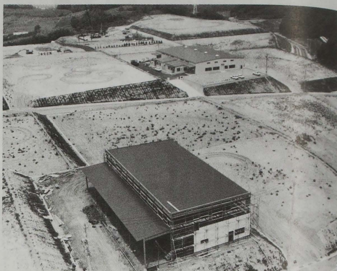
進出企業の社屋建設が進む東塩田林間工業団地
