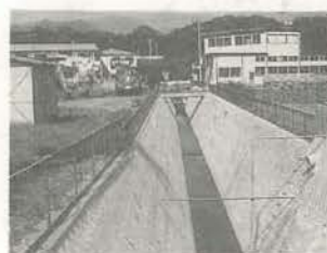
一部改修された常田川
