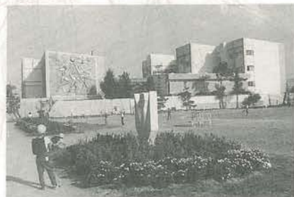
工事が進む第六中学校
