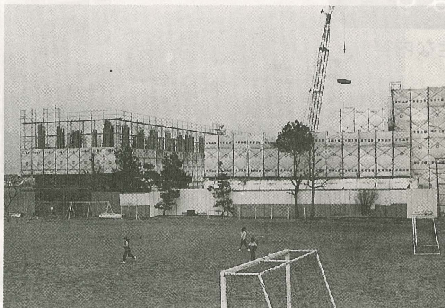
▲63年4月開校に向けて建設が進む第六中学校
