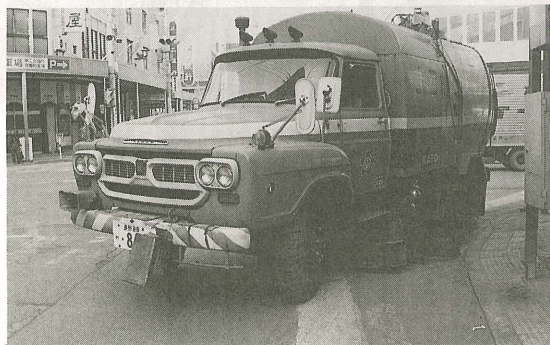
粉じん収集車による道路清掃
