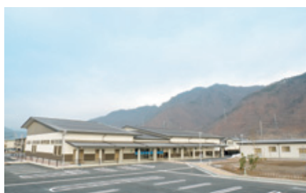
新たな地域の生涯学習の拠点となる西部公民館 (平成30年1月竣工)
