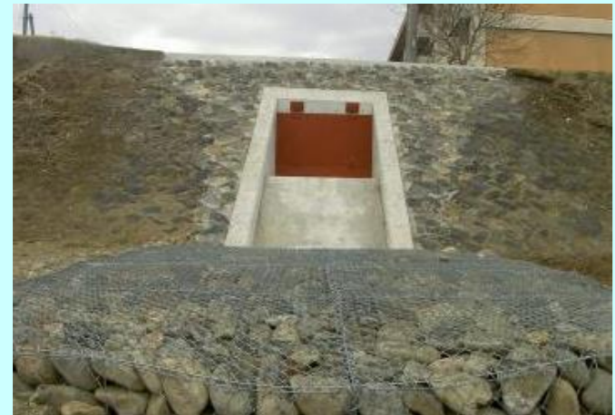
【依田川橋排水路】
