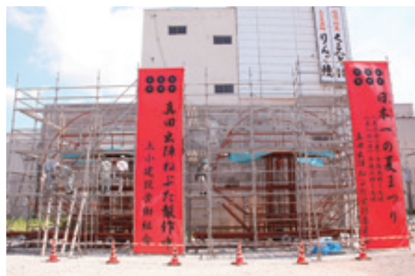
大灯ろうの照明設置作業
