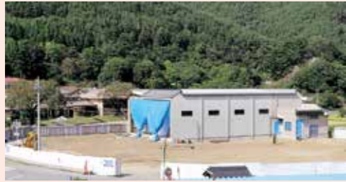
解体が終わり更地になった敷地(9月30日)
