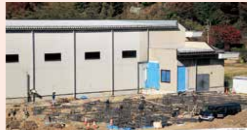
南側建物の基礎工事が進む(11月6日)
