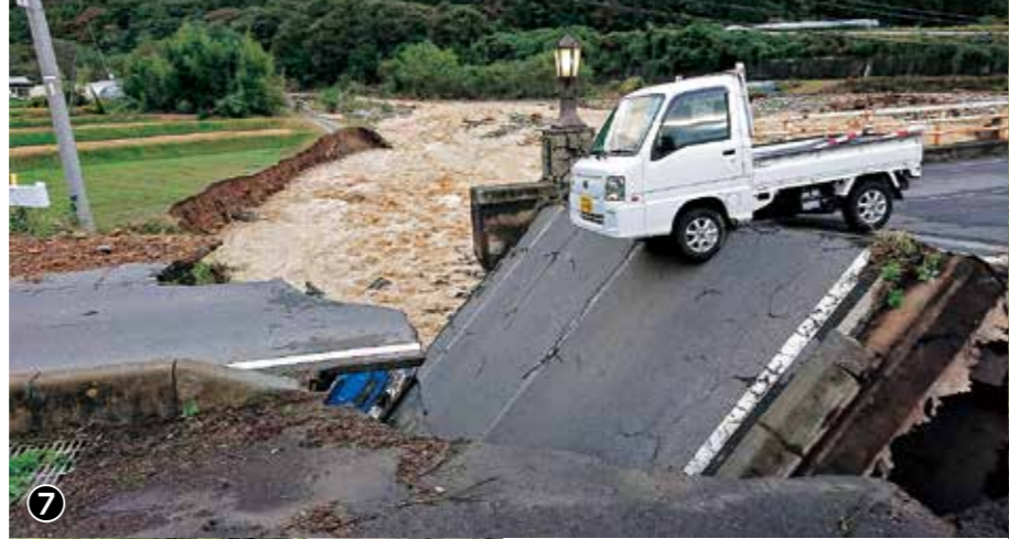
①雲溪荘へ通じる市道小沢根線 ②中島橋は護岸が浸食 ③唐沢川上流の土砂流出と倒木 ④道路が陥没した小寺尾橋 ⑤土砂流出により唐沢のアジサイ公園はほぼ全滅 ⑥武石峠へ通じる県道美ヶ原公園西内線 ⑦武石新橋の道路陥没 ⑧小沢根保代橋の橋脚洗掘の現場確認 ⑨ボランティアの方と武石新橋を歩いて渡る下本入以西の小学生
