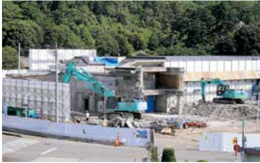
解体が進んでいる旧武石公民館(9月6日現在)
