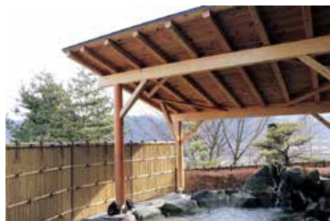
うつくしの湯では、今年度大浴場洗い場給水湯管の改修、露天風呂の垣根の改修と屋根の設置工事を行い、リニューアルしました。
