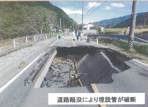
道路陥没により埋設管が破断
