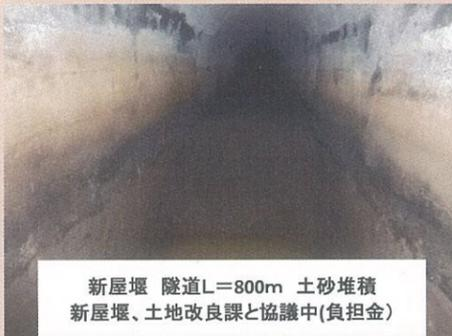
新屋堰 隧道L=800m 土砂堆積
