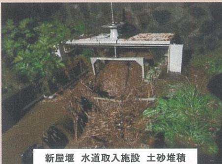
新屋堰 水道取入施設 土砂堆積
