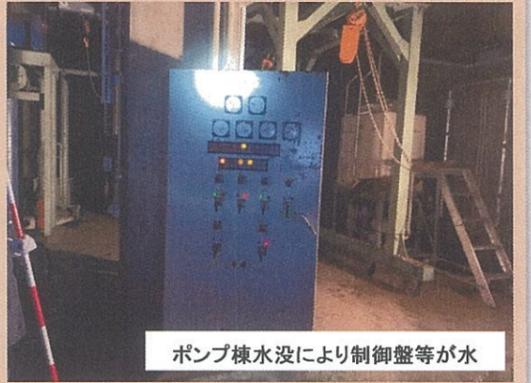
ポンプ棟水没により制御盤等が水
