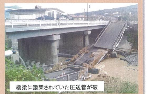
橋梁に添架されていた圧送管が破
