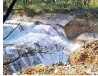
▲堂坂の頭首工
