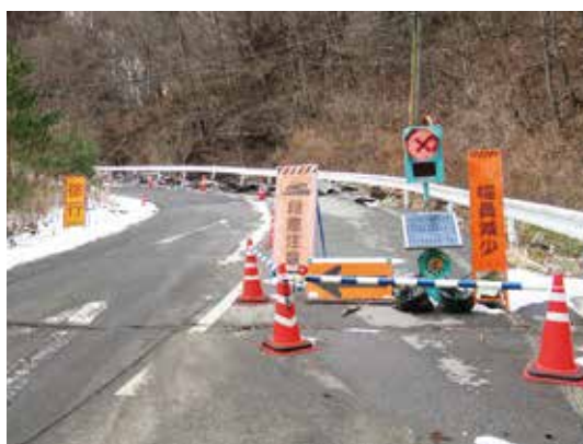
仮舗装を終えた現在の状況
