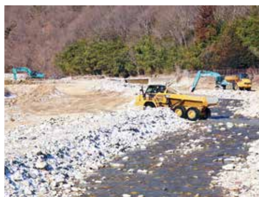
武石新橋上流の武石川の河床整理
