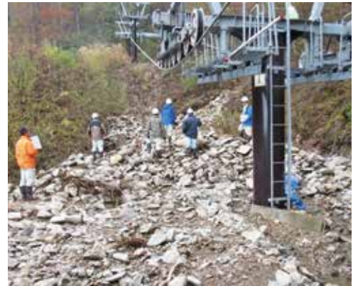
▲リフト乗り場への土砂流入
