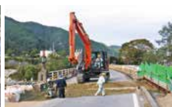
防災支援協会による仮復旧工事
