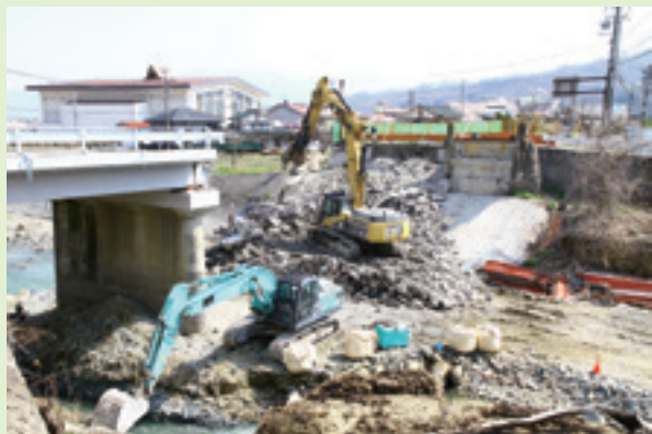
内村橋 解体の様子(4/16撮影)
