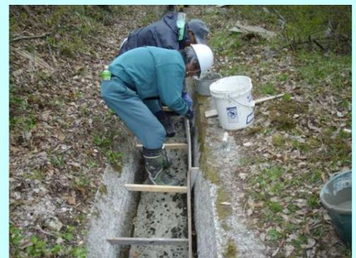
用水路 破損箇所への補修
