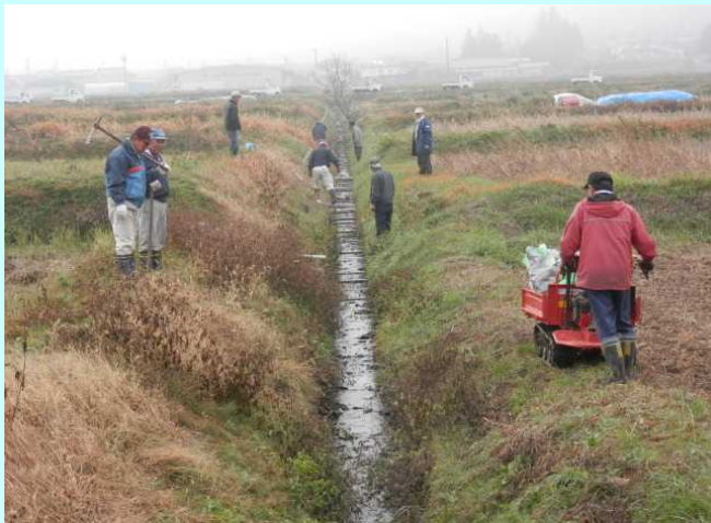
三ヶ沖排水路の補修
