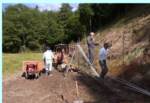
鳥獣防護柵の補修
