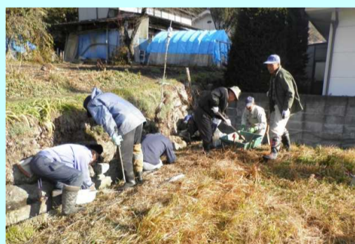
水路の目地詰め
