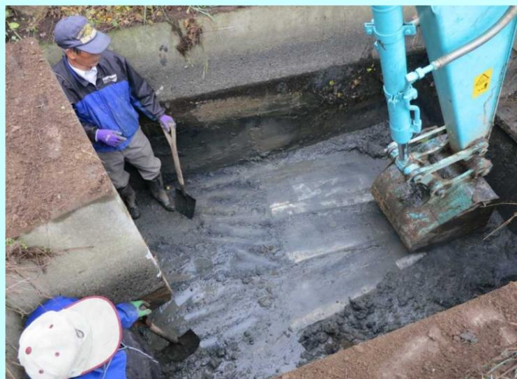
旧県道の下を通る水路の沈砂池の泥上げ
