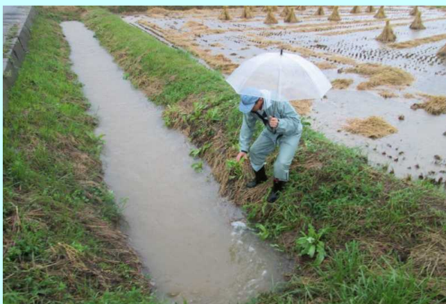
台風による大雨後の見回り
