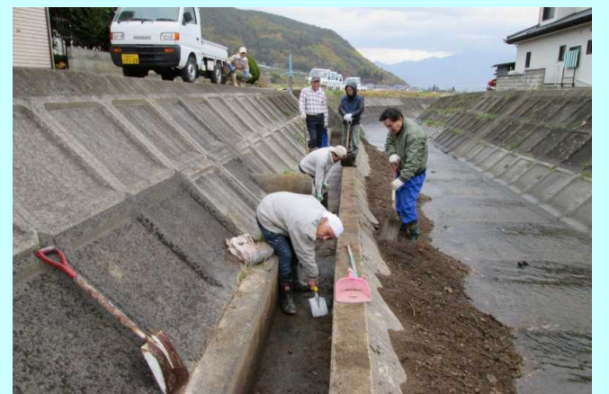
阿鳥川取水口の土砂撤去
