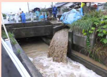
650m隧道に堆積した土砂の搬出
