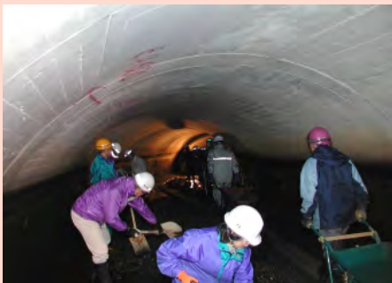
650m隧道に堆積した土砂の搬出
