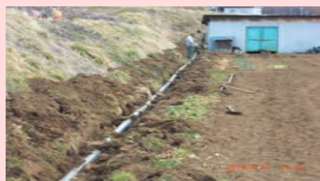
資源向上(長寿命化)としての暗渠埋設工事
