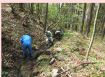
山間部の水路整備作業
