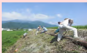
法面への小段の設置作業風景
