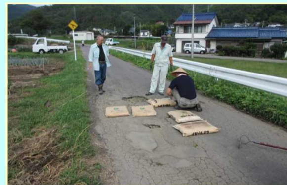
傷んだ農道の補修をしています。
