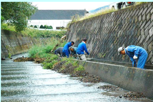
浦野川にある取水工(水路)の泥上げを毎年2回以上実施
