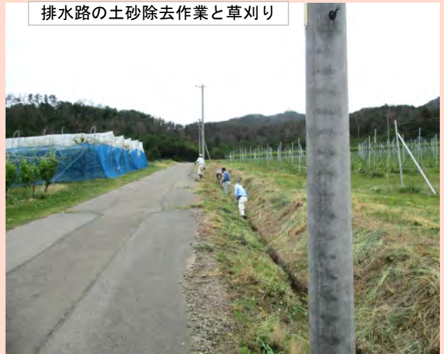
排水路の土砂除去作業と草刈り
