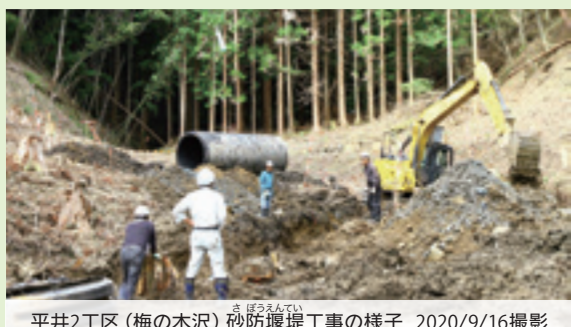
平井2工区（梅の木沢）砂防堰堤工事の様子 2020/9/16撮影
