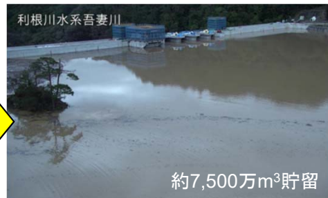
10月15日 17:00 状況写真
