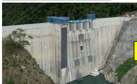
10月11日 状況写真
