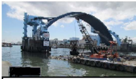
水門の開閉のための浚渫
