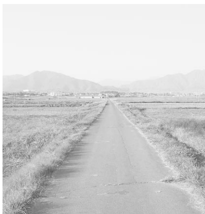
老朽化が目立つ用水路や農道
