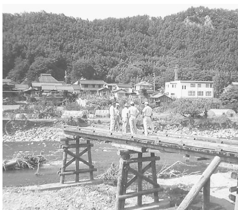
建設消防委員会による災害現場視察(馬坂1号橋)
